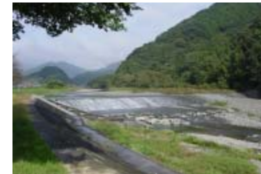
瀬戸川 藤枝市宮原 頭首工
